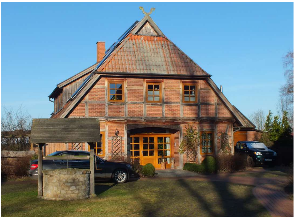
Bebauung der Nr. 30 im Jahre 2016 (Foto: Weigang)
