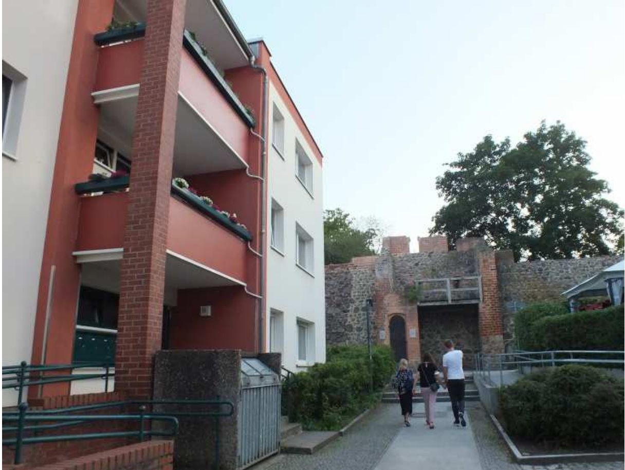
Saniertes Plattenbau an der westlichen Stadtmauer
