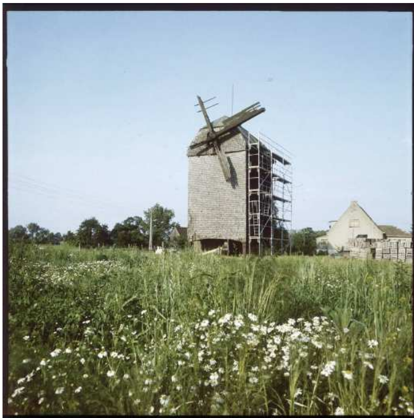
Bernd Maywald dokumentierte die Restaurierung in den 1980er Jahren
