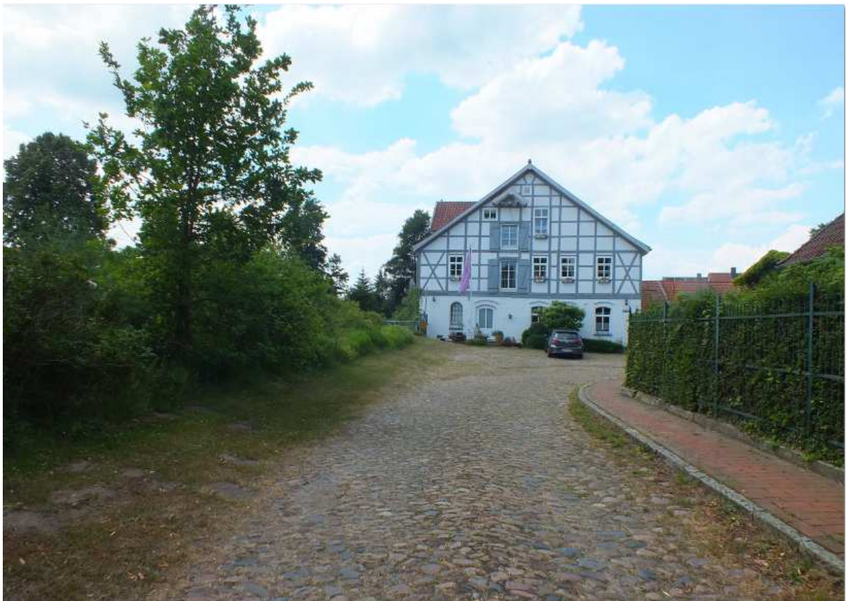
Links ist der Wall zum Mühlteich erkennbar
