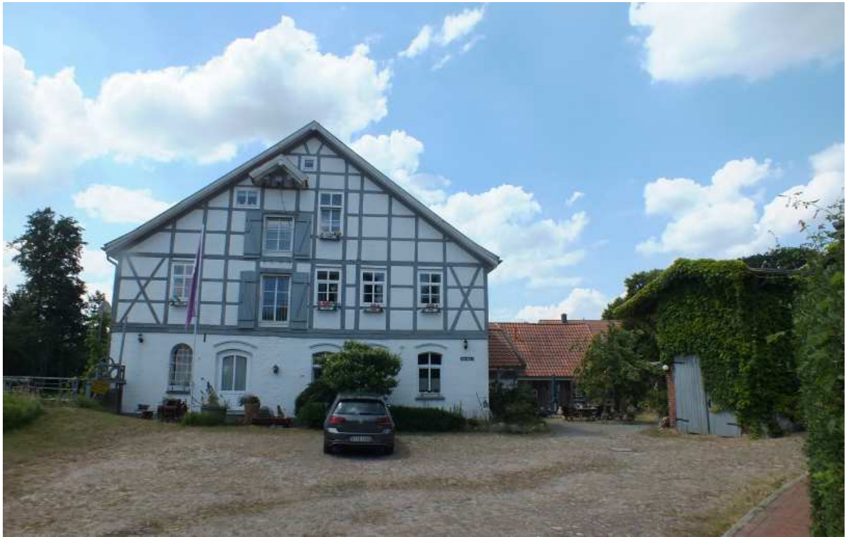
Zuweg zur Mühle aus Pflastersteinen
