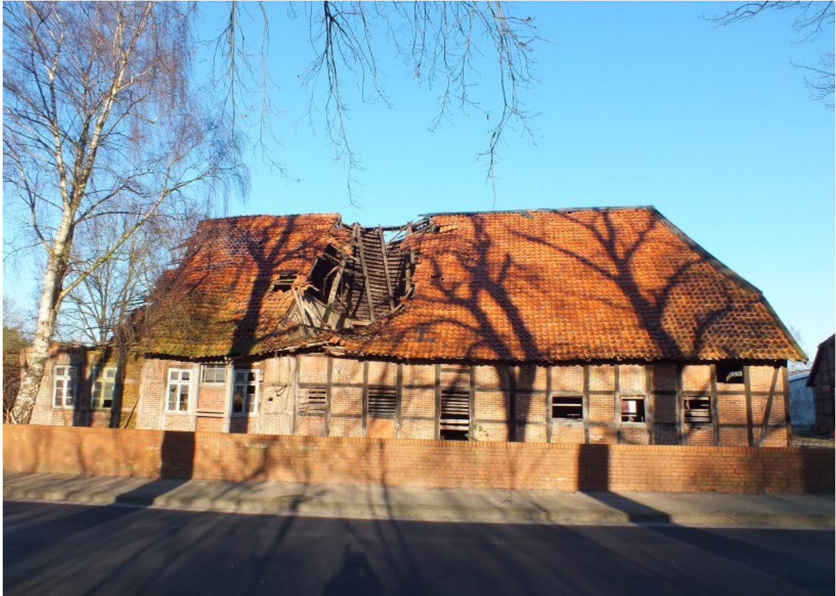
Hof Abbensen Nr. 20 vor dem Abriss (Foto: Weigang)
