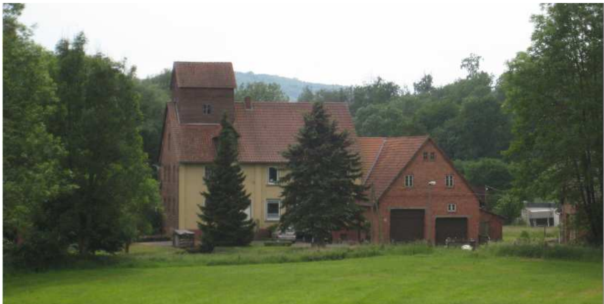
Nahe der Schwarzen Mühle in Rolfshagen, Auetal/Niedersachsen, gab es im Bereich der heutigen Kläranlage auch eine „Cementmühle“ (Bild: Weigang)
