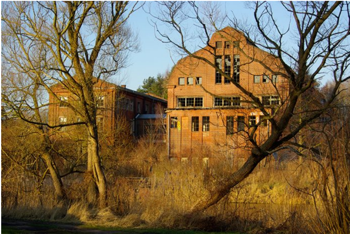
Kraftwerk Heegersmühle bei Ebeswalde (aus: www.rottenplaces.de )
