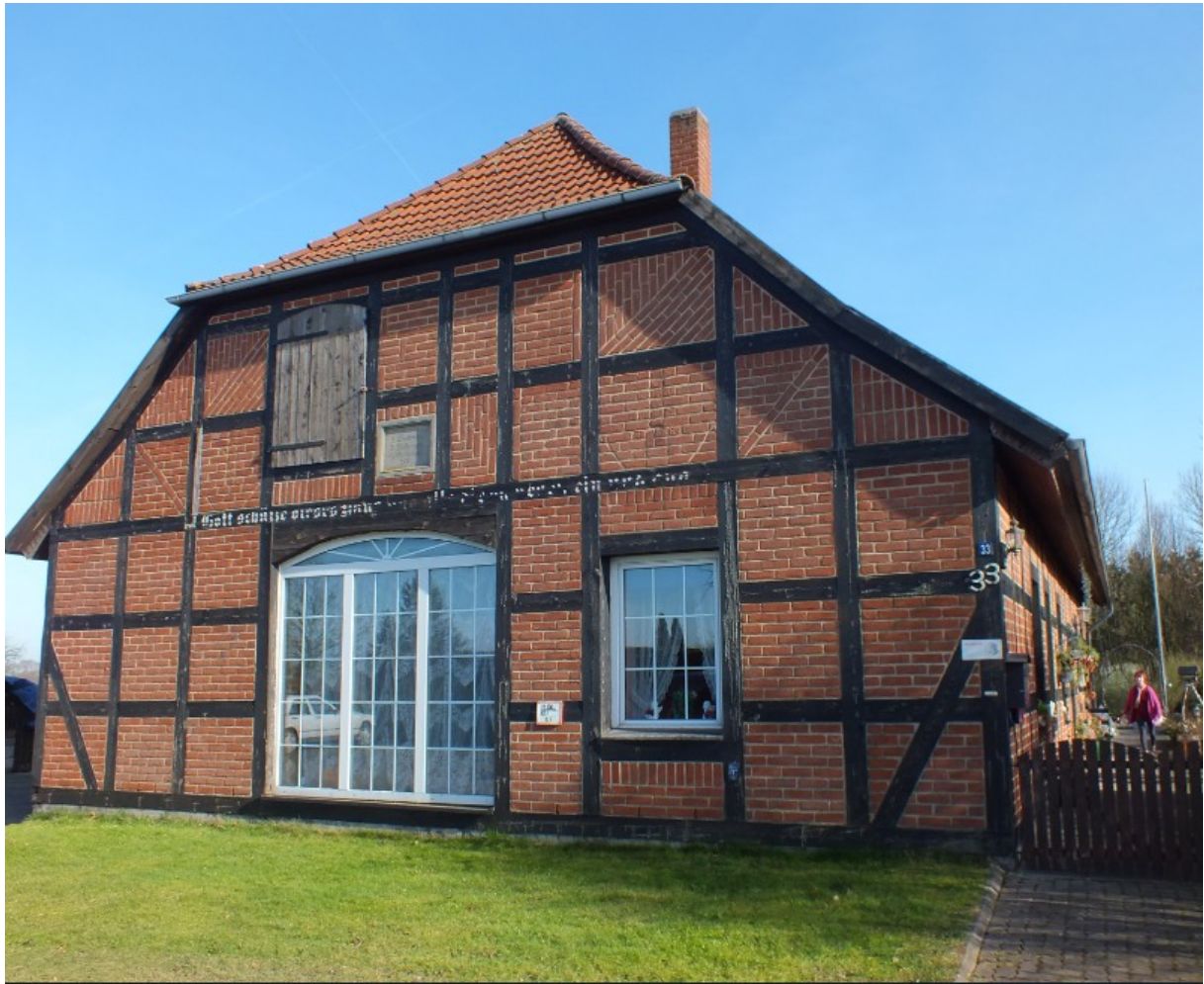
Hofstelle Frielingen Nr. 32 mit der Hausnummer 33 (Bild Weigang)
