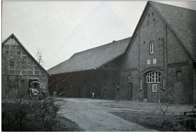
Hof Nr. 22 in einer alten Aufnahme
